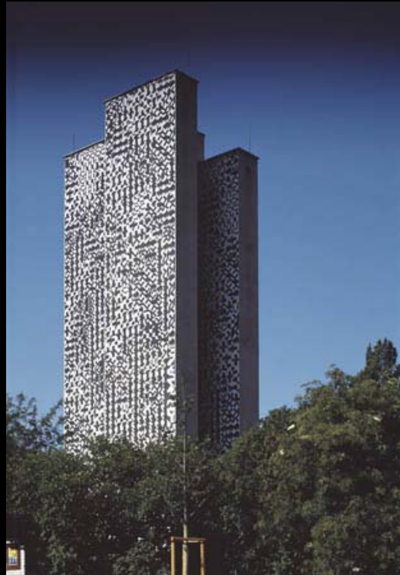
Výduchy letenského tunelu
